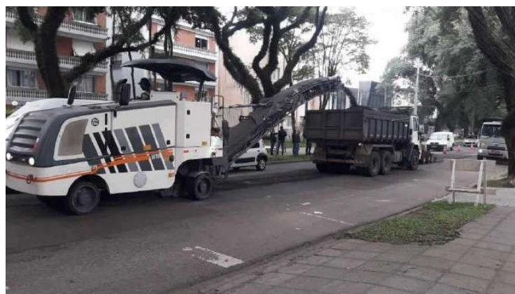
Figura nº 11 – Execução serviço de fresagem em rua de Curitiba.
