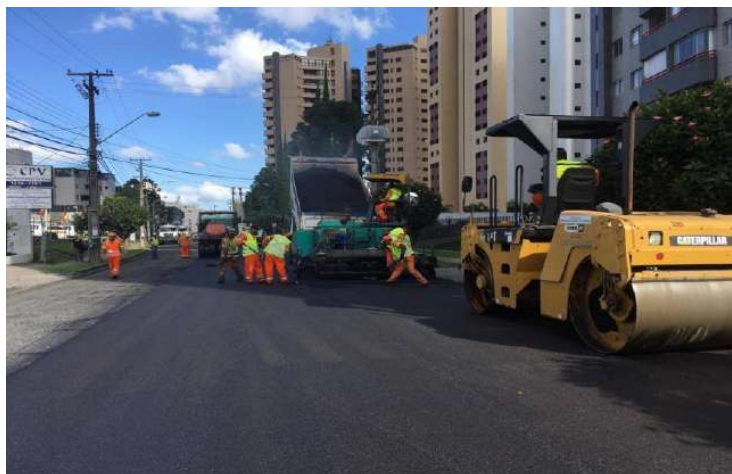
Figura nº 10 – Execução de pavimentação asfáltica em rua de Curitiba.
