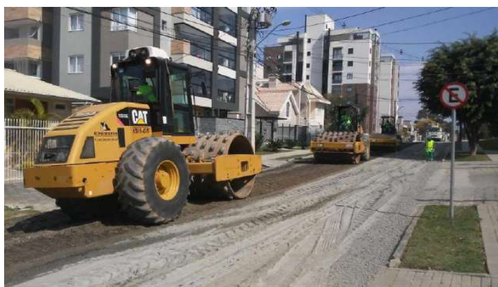
Figura nº 09 – Execução do serviço de reciclagem em rua de Curitiba. FONTE: Acervo da Empresa.
